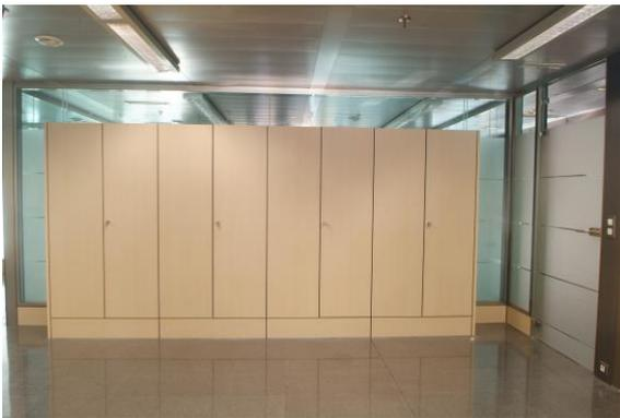
Tabique armario con montante de vidrio laminar de seguridad .
